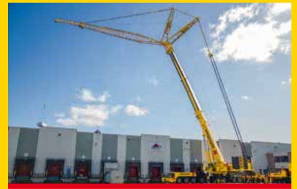
Van Dijk De Meern B.V., Harmelen 650-tons weg-/terreinkraan (o.a. Maarssen)
